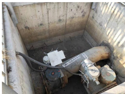
图 2.5-6 初期雨水收集池及配套切换装置
