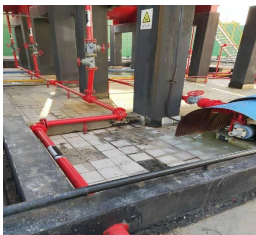
图 2.5-10 酸碱储罐区防渗措施已完善
